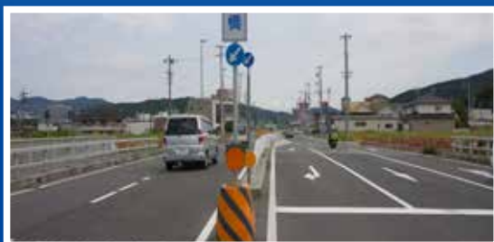
県道名古屋多治見線の 4車線化完了ですますます便利に。
